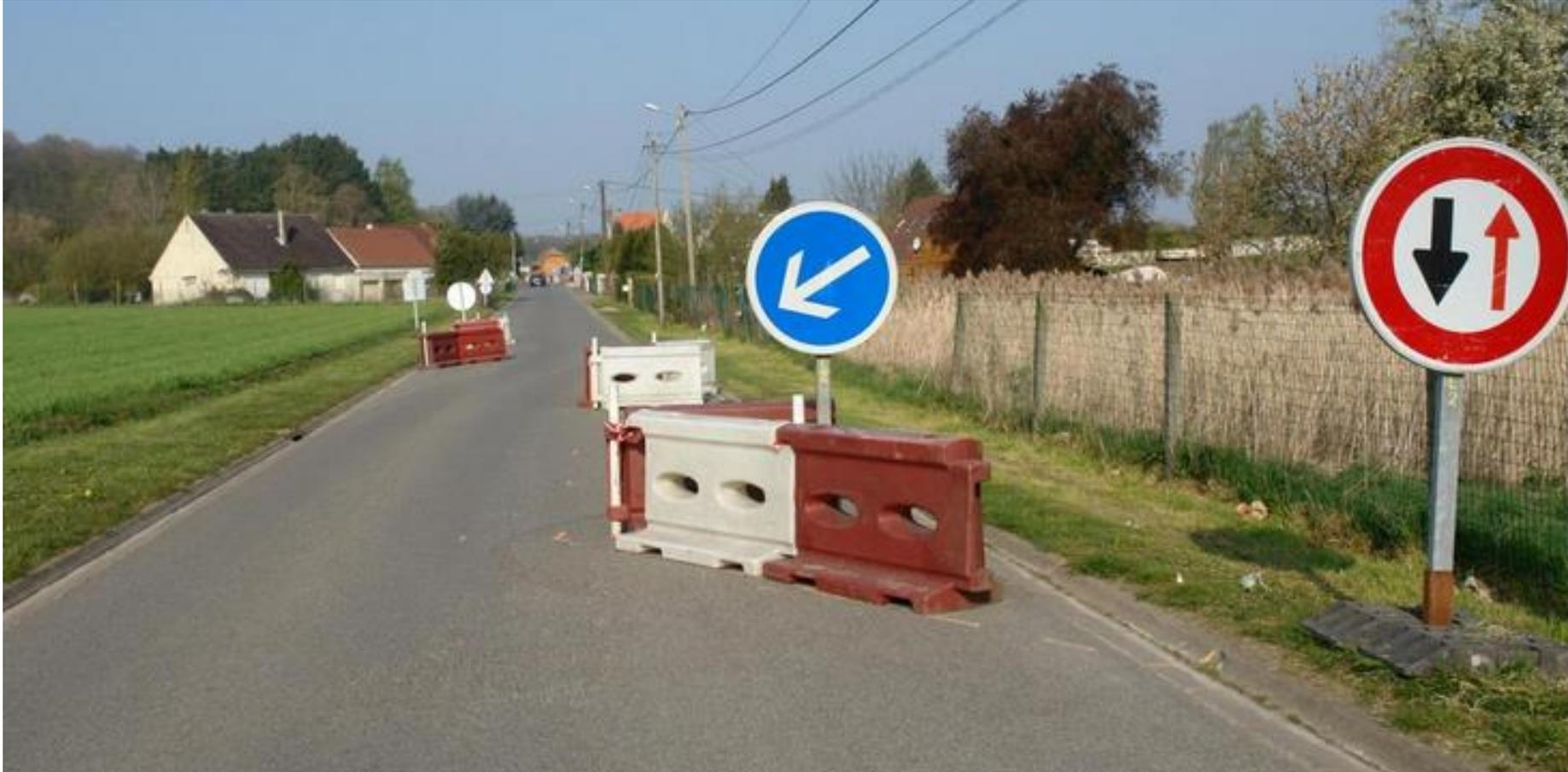
Essai d'écluse double
