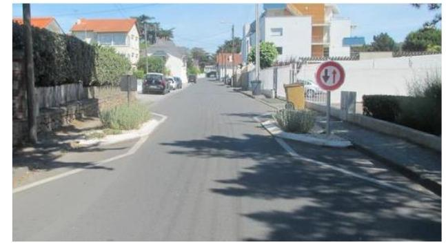
**L'écluse simple centrale** : les avancées de trottoir (une à droite et une à gauche) sont concentrées au même endroit - si une autre voiture (A) arrive en face on s'arrête (B) et on attend.
