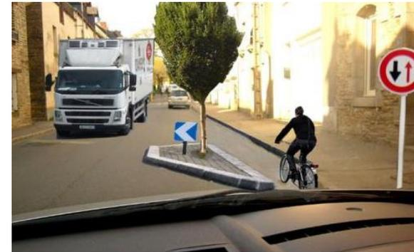
**L'écluse double** : les avancées de trottoir (une à droite puis une à gauche) sont à deux endroits successifs rapprochés (16-17 m) - si une autre voiture (A) est dans l'écluse on s'arrête (B) et on attend. **C'est le MEILLEUR dispositif pour modérer la vitesse** car si le trafic est faible (exemple la nuit ou le dimanche) la déflexion de trajectoire fait ralentir, et s'il y a beaucoup de trafic, la présence d'une voiture venant en face oblige à s'arrêter.
